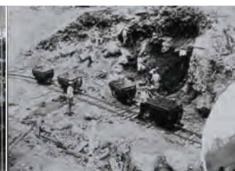
■掘り出した鉱石は、トロッコで運搬した
