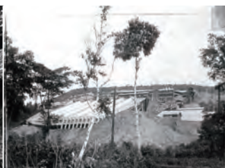
■わずか1年で建設された巨大な製錬所
